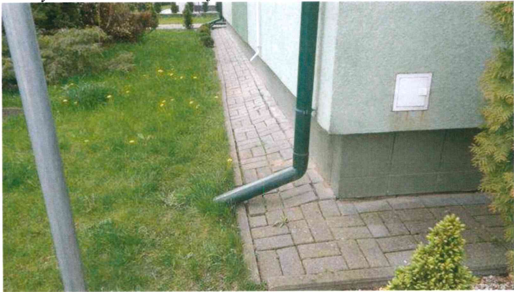
PT Wysokie Mazowieckie – foto nr 2
