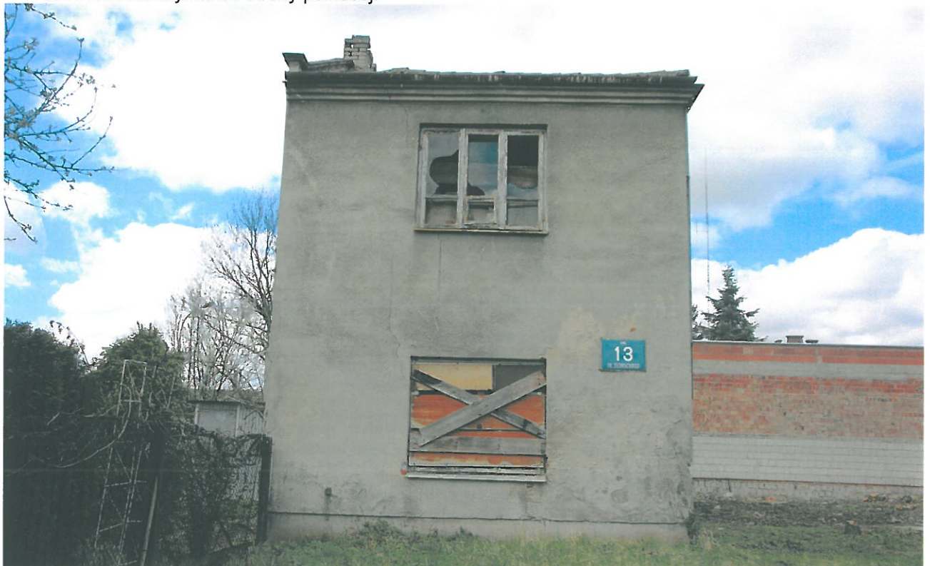
Fot.2 . Widok budynku od strony wschodniej.
