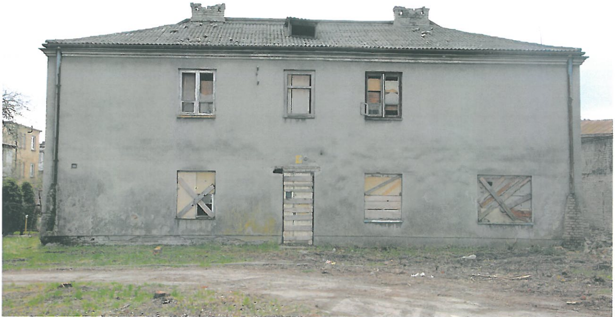
Fot.1. Widok budynku od strony północnej.
