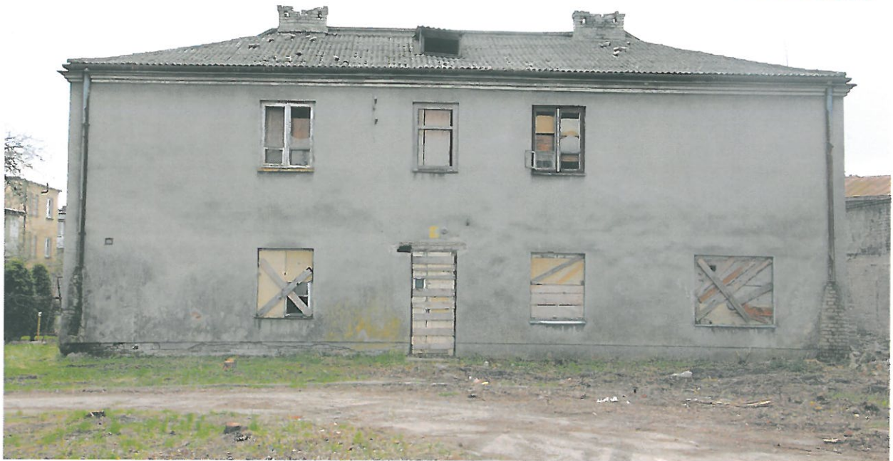
Fot.1. Widok budynku od strony północnej.
