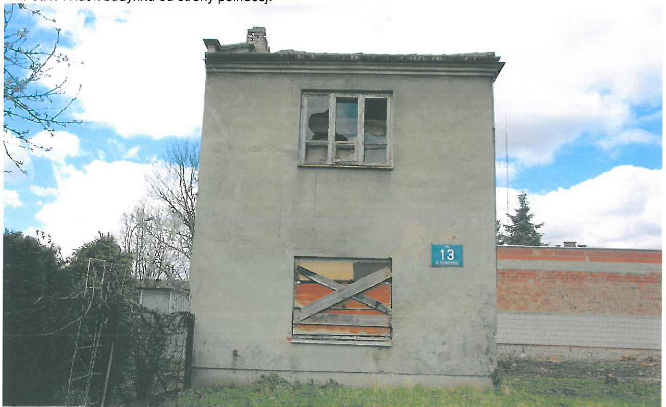
Fot.2 . Widok budynku od strony wschodniej.
