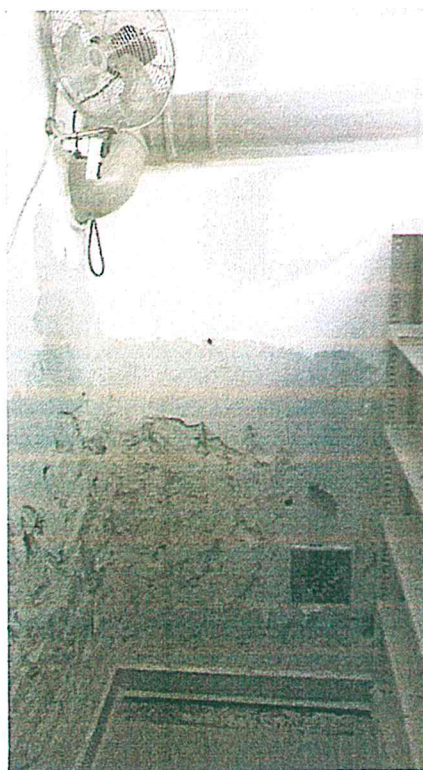
Zdj. 7-8 Pomieszczenie 0/1 Archiwum Duże. Widoczne wyjście kanalizacji przy suficie ściany północnej oraz wywietrznika przy posadzce na ścianie wschodniej. Widoczny jeden z dwóch wiatraków wymuszających obieg powietrza. Skucie tynku na wysokość około 70cm.
