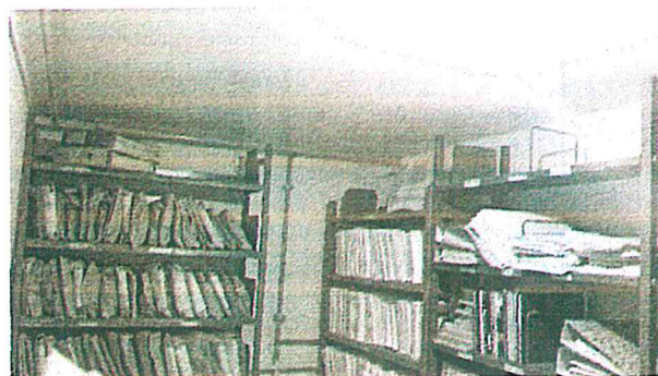
Zdj. 7-6 Pomieszczenie 0/3 Archiwum małe – wejście gazu do budynku
