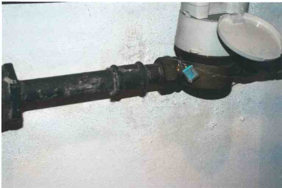
Fot.1. Miejscowa krystalizacja soli na powierzchni tynku
