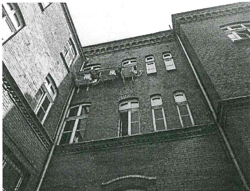
Fot. 4 – Osłona klimatyzatorów do wymiany
