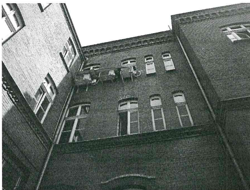
Fot. 4 – Osłona klimatyzatorów do wymiany
