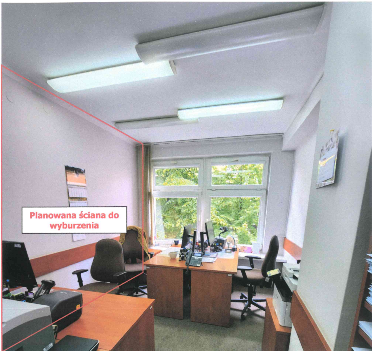
Planowana ściana do wyburzenia
