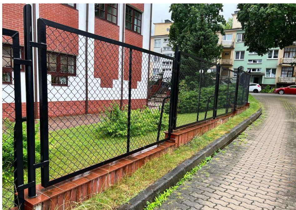
Fot.8. Widok ogrodzenia od strony północno-zachodniej z paneli siatkowych - przeznaczone do remontu
