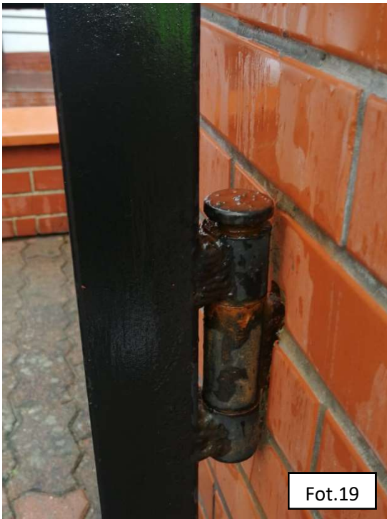
Fot. 19., Fot. 20. Widok skorodowanych części metalowego ogrodzenia przed budynkiem oraz zielone zanieczyszczenia na ich powierzchni
