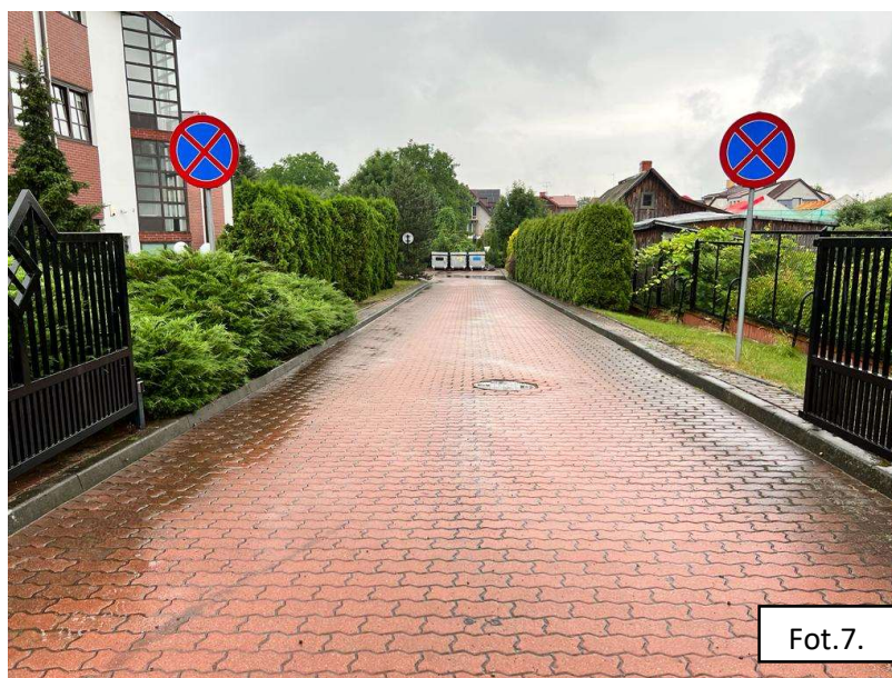
Fot.7. Widok utwardzenia terenu wokół budynku administracji publicznej
