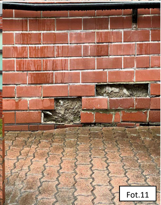
Fot. 8.- Fot. 11. Widok zniszczonych schodów zewnętrznych – znaczne ubytki, wykruszenia betonu, nierówne powierzchnie wykończenia
