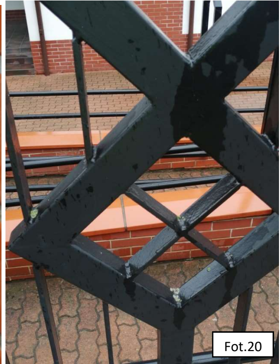
Fot. 19., Fot. 20. Widok skorodowanych części metalowego ogrodzenia przed budynkiem oraz zielone zanieczyszczenia na ich powierzchni
