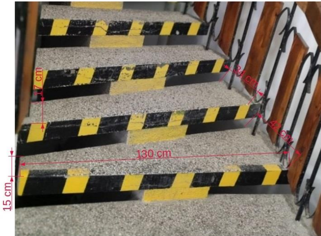
Zdjęcie nr 3 – schody kręte 3 szt.
