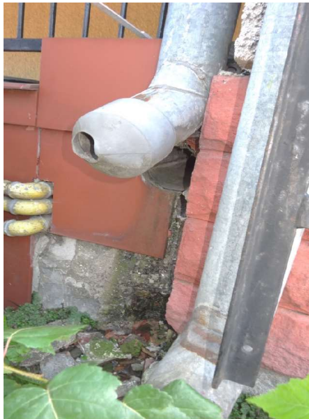
Zdjęcie 14. Wylot rury jw. wraz z rurą zadaszenia na odpady
