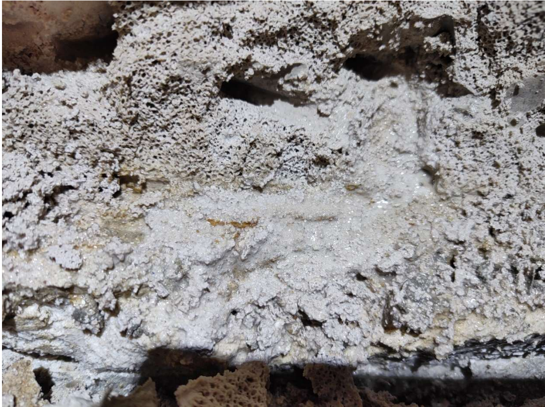
Zdjęcie 7. Błyszczące skropliny wody płynące ze ściany
