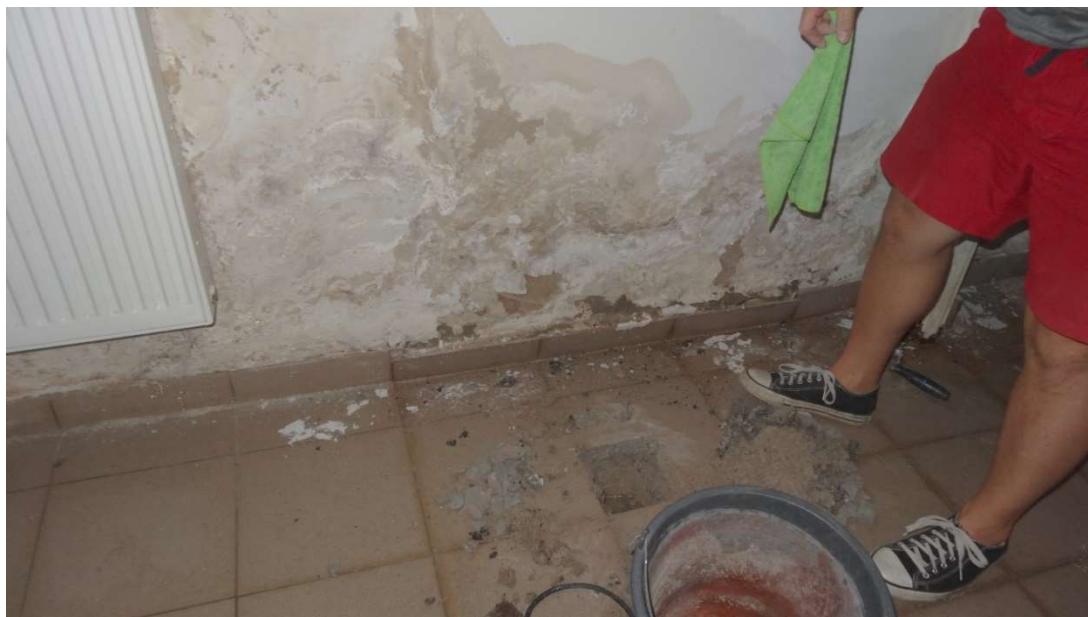
Zdjęcie 1. Lokalizacja odkrywki przy dawnym wejściu do piwnicy
