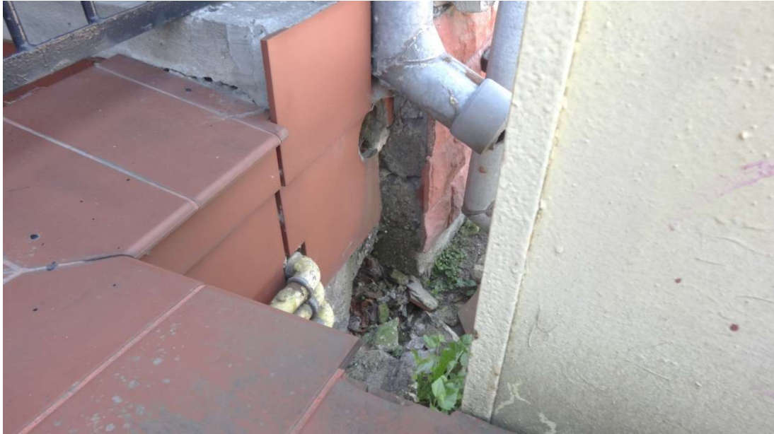
Zdjęcie 13. Wylot obmurowanej rury spustowej
