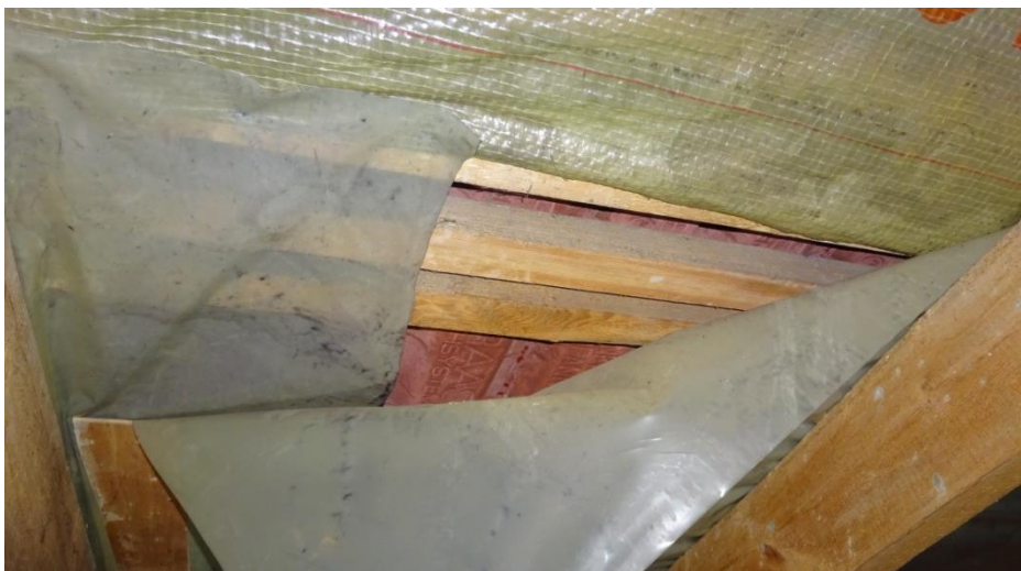
Foto nr 5-Zerwana folia dachowa, widoczne różne gatunki folii o różnych parametrach technicznych
