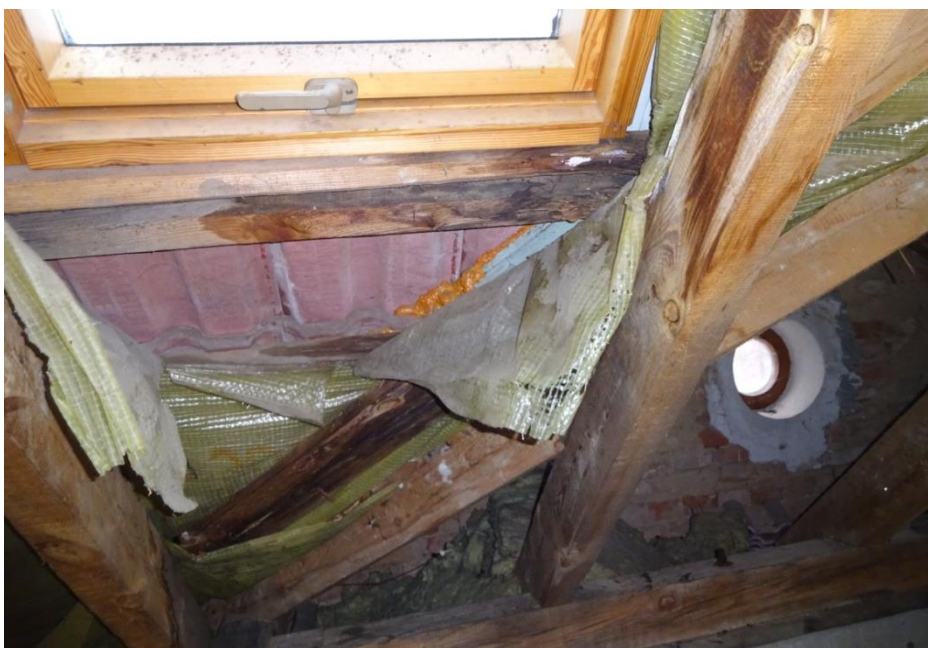
Foto nr 5-Zerwana folia dachowa, widoczne różne gatunki folii o różnych parametrach technicznych
