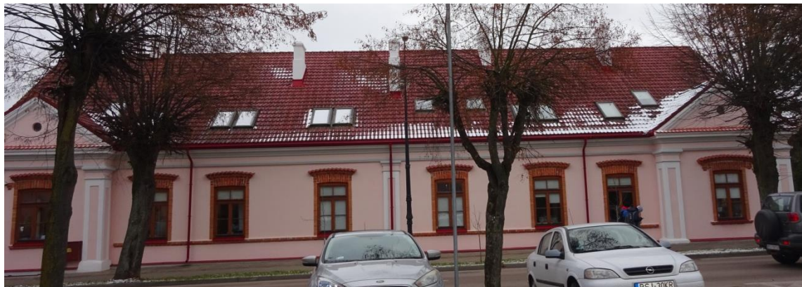
Foto nr 7- elewacja frontowa
