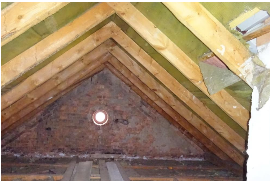
Foto nr 4- widok strychu nad poddaszem użytkowym
