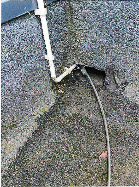
Zdjęcie 3. Odprowadzenie wody z tarasu
