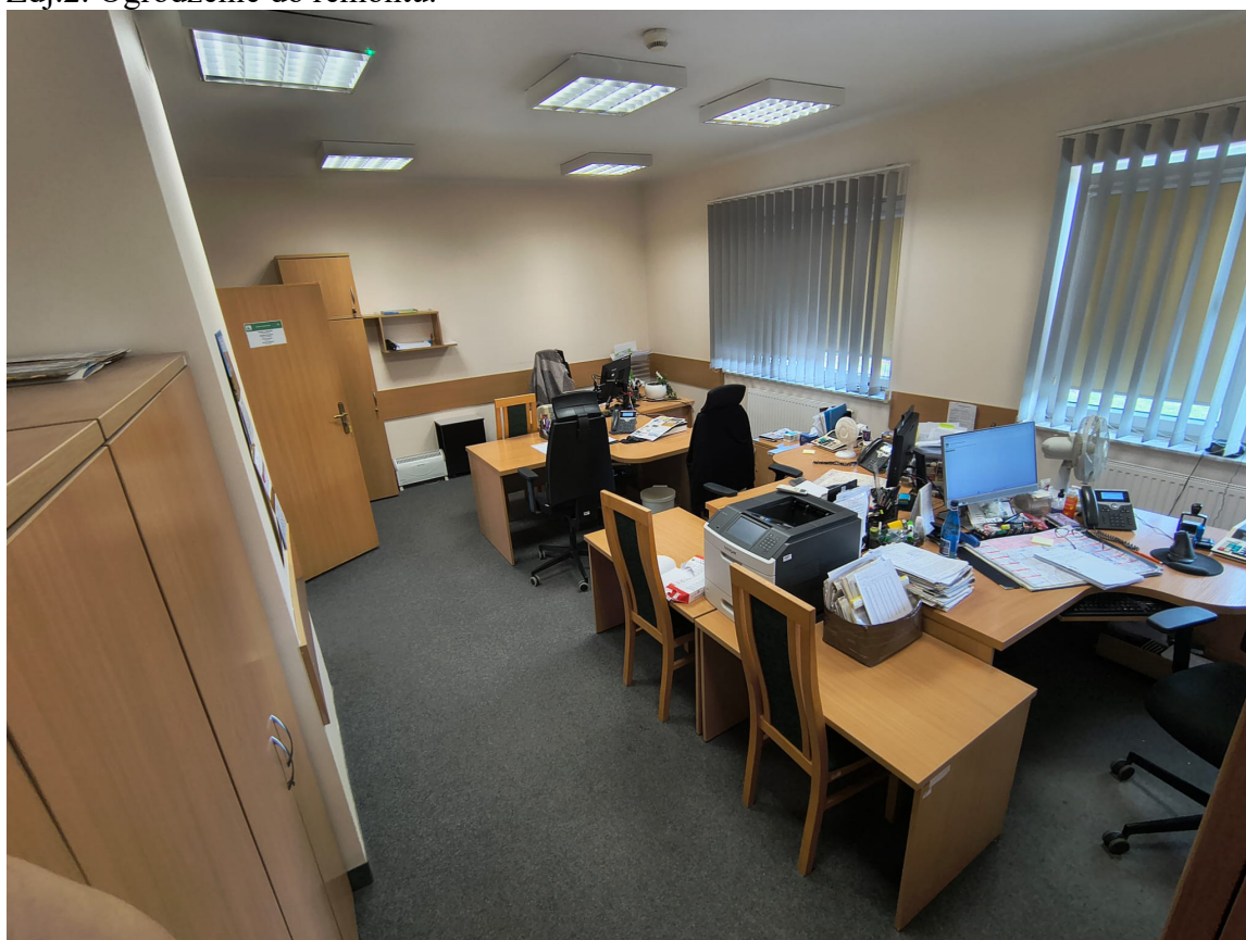
Zdj.3. Wykładzina do wymiany na panele, ściany do malowania.
