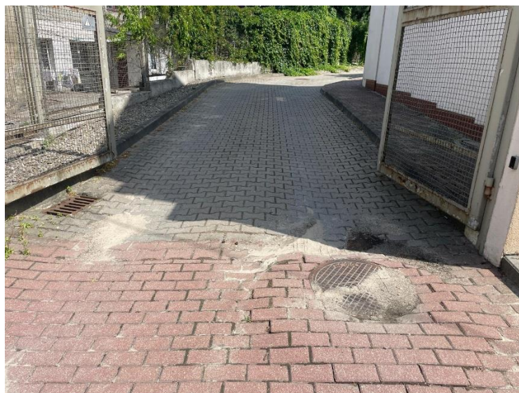
Istniejące utwardzenie z kostki betonowej przeznaczone do remontu – brama wjazdowa
