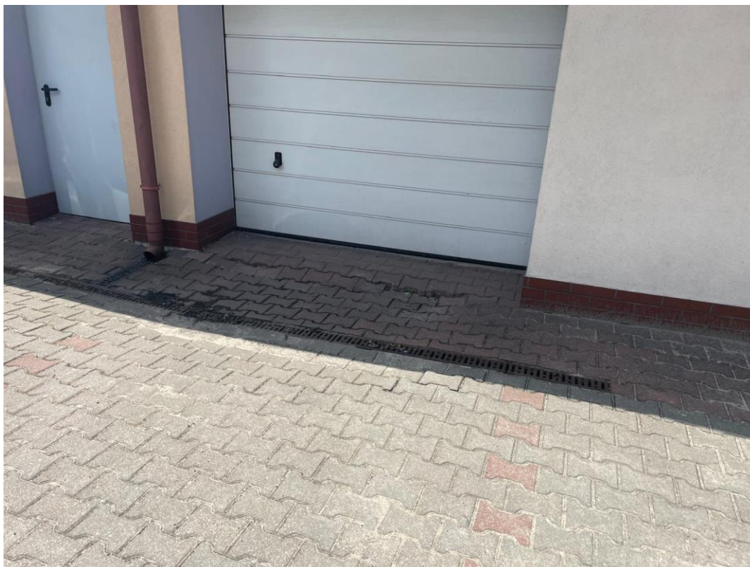
Istniejące utwardzenie z kostki betonowej przeznaczone do remontu – utwardzenie przy budynku
