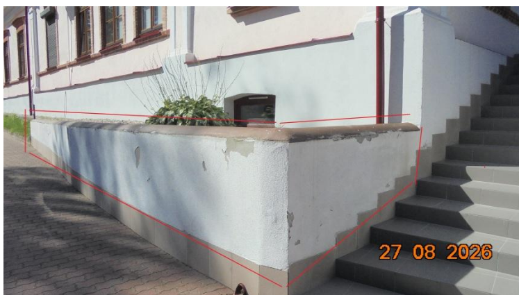
3. Naprawa miejscowa ubytków murku przy furtce wejściowej
