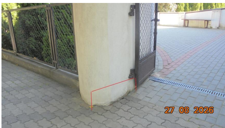
4. Naprawa miejscowa ubytków elewacji przy wejściu bocznym
